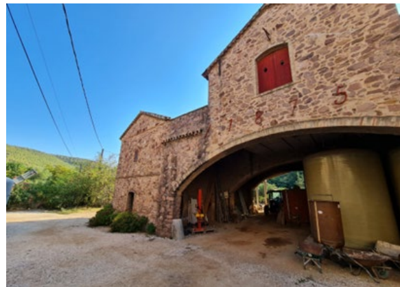
Vue Nord du bâtiment
