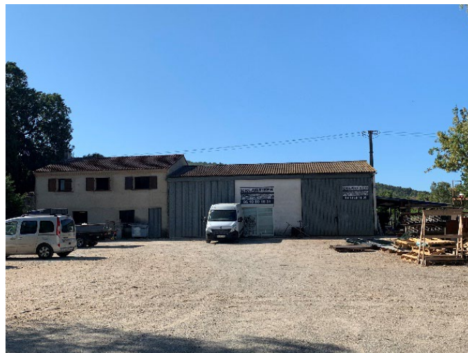
Vue Nord du bâtiment
