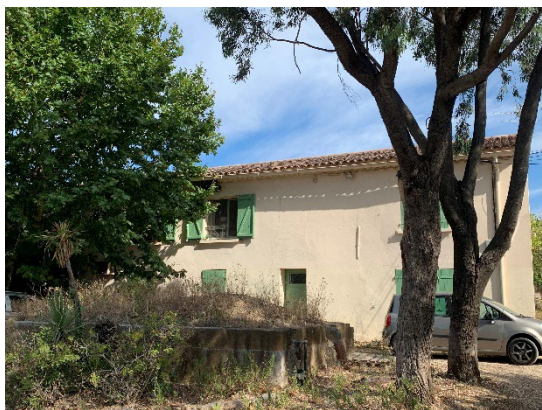
Vue Sud du bâtiment
