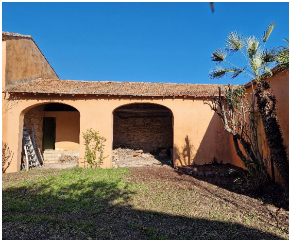
Vue Sud du bâtiment en fond de cour (RdCh)
