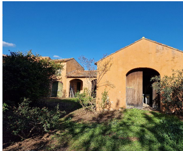
Vue Sud du bâtiment en avancée (RdCh)
