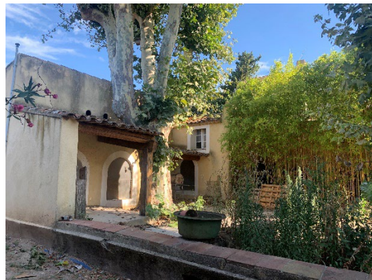
Vue Sud du bâtiment en R+1
