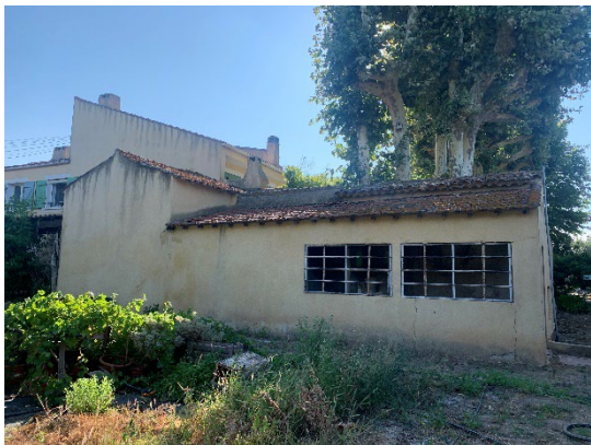
Vue Ouest du bâtiment annexe (RDC)
