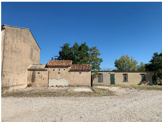
Vue Sud du bâti et des anciennes écuries
