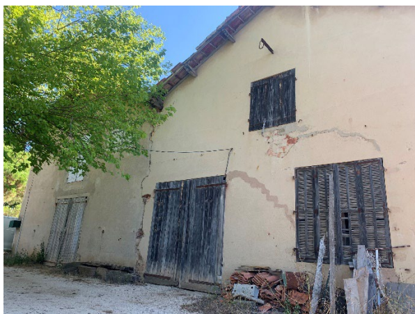
Vue Ouest sur le bâtiment
