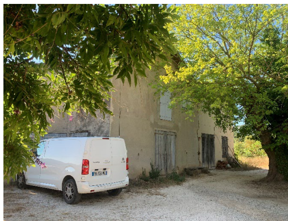
Vue Ouest sur le bâtiment
