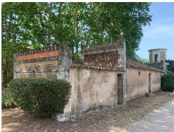
Vue Ouest du bâtiment
