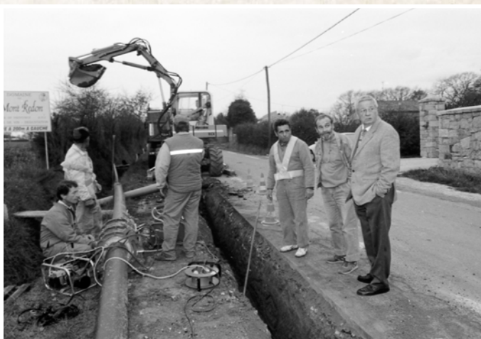
Gérard SIMON a toujours suivi de près les travaux réalisés sur le territoire communal. On le voit ici en 1995, aux Martins lors de la pose d'une conduite, en compagnie de Michel SURREL, responsable des services techniques municipaux.
