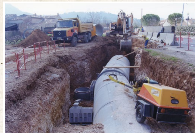
Construction du pluvial à la fin des années 90. On voit la conduite enterrée qui achemine les eaux de pluie à partir des Arquets vers le Gapeau. La photo est prise à proximité du hameau de Notre Dame, dont on distingue les toitures à gauche derrière le camion, et à droite, la chaussée de l'avenue Pasteur.
