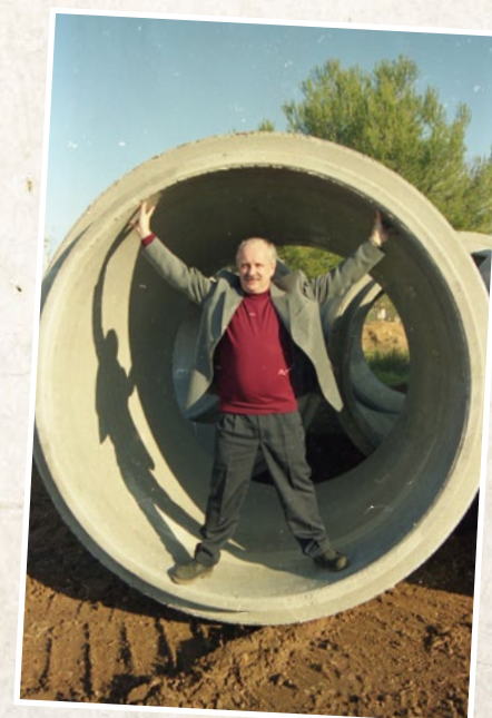
Daniel GIRAUDO, directeur des Services Techniques Municipaux au moment des travaux, nous donne une idée de la taille d'un élément de la conduite du pluvial, avant qu'elle soit enterrée.
