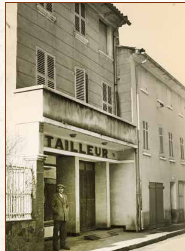
Monsieur Henri pose devant son nouvel atelier situé presque en face du premier, au numéro 7. Le rez-de-chaussée de la maison abrite aujourd'hui, le bureau d'un expert comptable.
